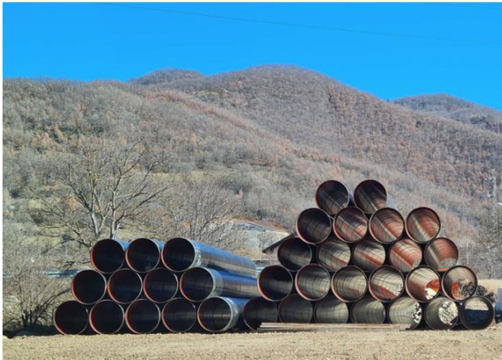
Stoccaggio di una parte delle tubazioni DN 900 mm. arrivate in cantiere
